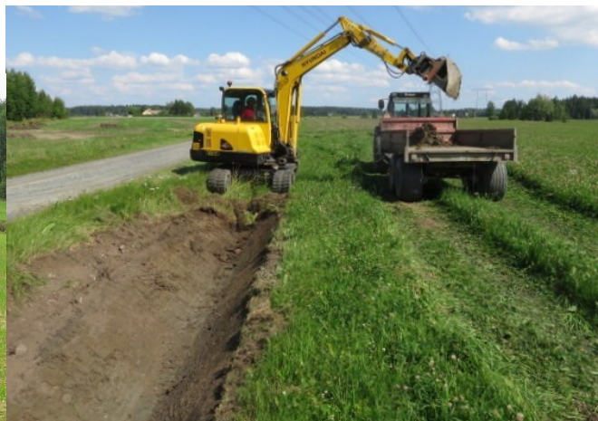
Bild 4. Vid rensning av omkretsdiken kan man köra dikesjorden i svackorna och jämna ut åker efteråt. Bild: Jukka Rajala.
